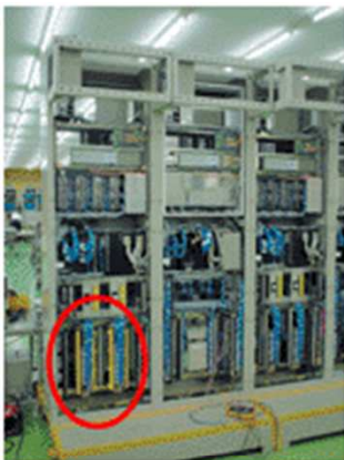
ワンタッチTB取付使用例 短絡板間の連結も簡単!!
